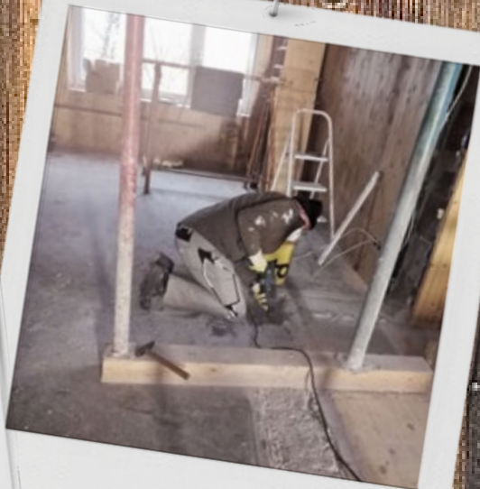
Bodenarbeiten mit schwerem Gerät.
