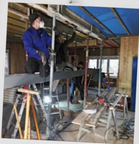
Das wichtigste Element des Umbaus: Der Stützbalken.
