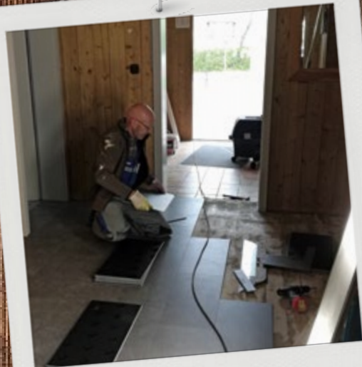
Endspurt: Wolfgang beim Verlegen des Bodens.
