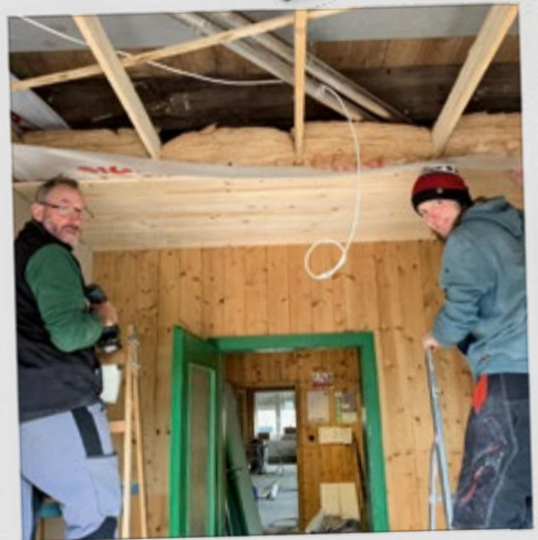
... neues Holz wird angebracht.
