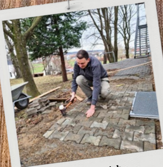
Auch im Außenbereich wird gewerkelt.
