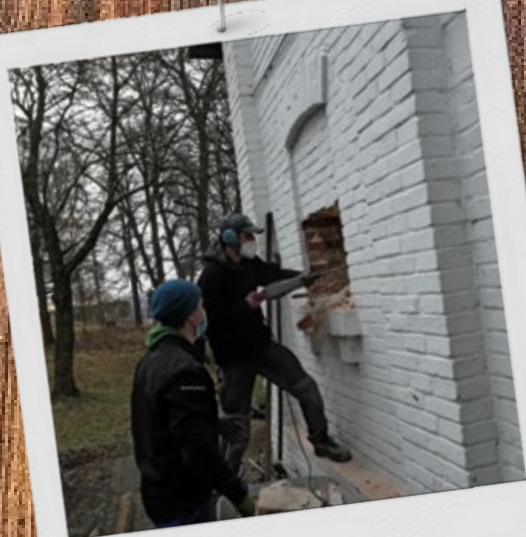
Auch der Schlagbohrer kommt zum Einsatz.
